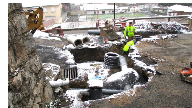
Vue des travaux au niveau de la montée de la Brolle, le 1er avril, sous une neige matinale...
